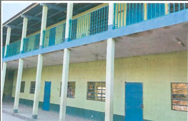
Foto 3: Pintura en el interior de la Escuela
