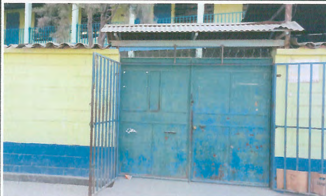
Foto 2: Remodelación de Muro Perimetral
